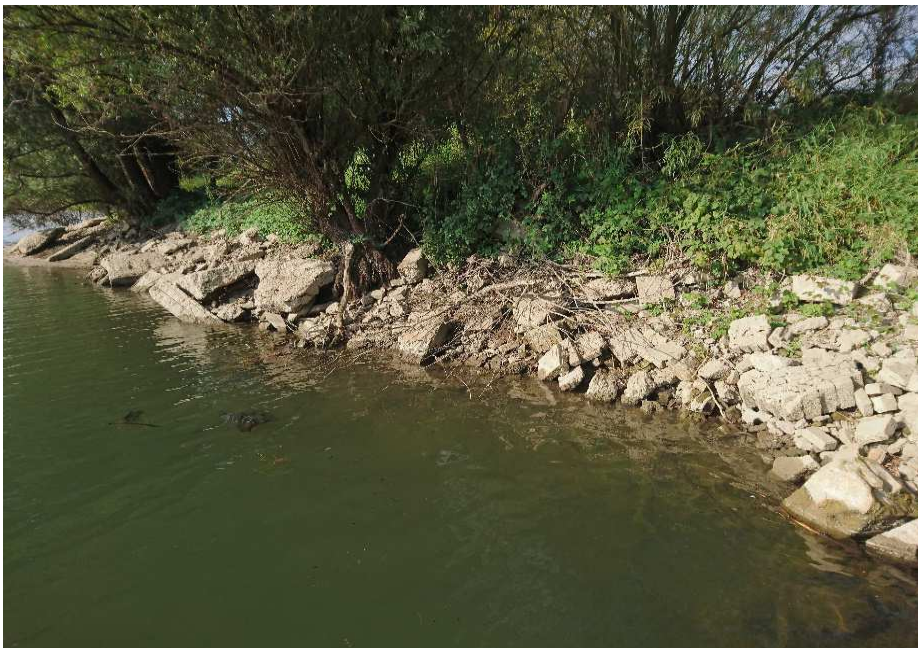
Foto 3.2. Overzicht van traject 2 in 2016: een oever met grote puinbrokken en plaatselijk overhangende wilgen. Linksboven is een deel van een kort zandstrandje te zien.
