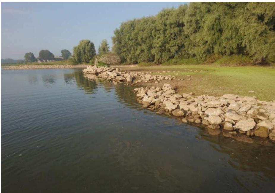
Foto 3.1. Traject 1 (2016) heeft over vrijwel de gehele lengte een oever van grote stenen; onder water vinden we hoofdzakelijk kleine stenen.
