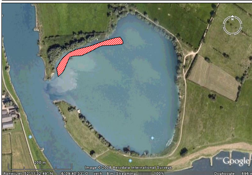
Figuur 2.1. Overzichtskaart van het zandgat (met een blauwe lijn omrand) en luchtfoto. Op de kaart is voor de plas en naaste omgeving situering van het Natura-2000 gebied “Uiterwaarden IJssel” weergegeven. Op de onderste luchtfoto is met arcering het gebied aangegeven waar in 2011 mijnsteen is aangebracht. Bron kaart: Topografische Dienst Emmen (1988); Luchtfoto: Google Earth.
